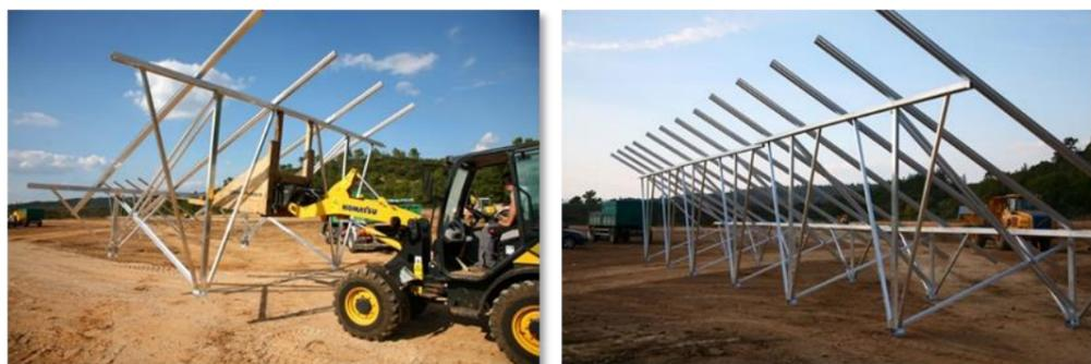
Photographie 2 : Exemple de structure porteuse métallique (Source : ENCIS Environnement)
